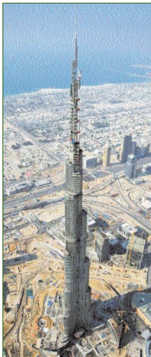
Рис. 1 Общий вид здания Burj Dubai. Фото JO Lee
