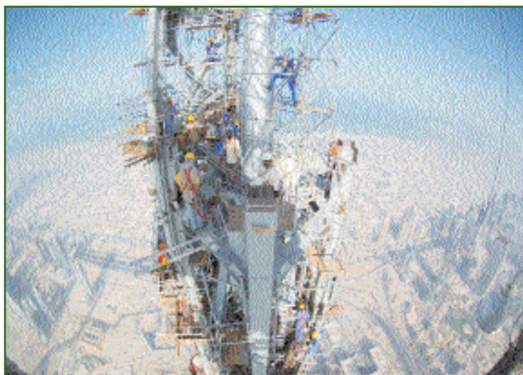
Рис. 6 Монтажные работы при установке стальной конструкции надстройки и шпиля (фото Lee In Ku)
